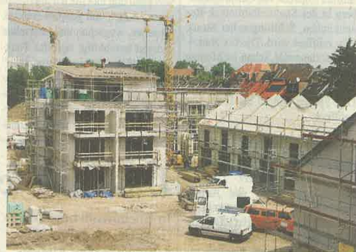
Die ersten Rohbauten der autofreien Siedlung in Nippes wurden nun vollendet. 2008 sollen alle Häuser fertig sein.
