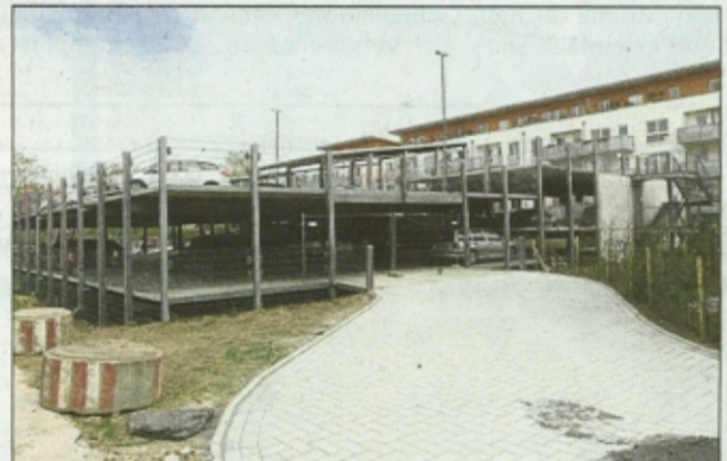
Das Parkhaus der autofreien Siedlung in Nippes. Alle Stellplätze sind vergeben. Fotos: Worring, Schwalger, Banneyer
