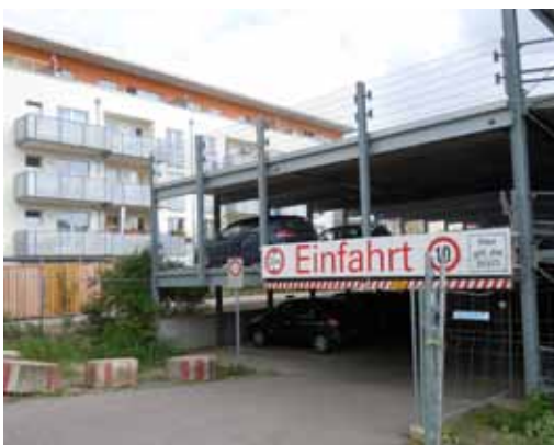
Parkhaus am Rande der Siedlung
